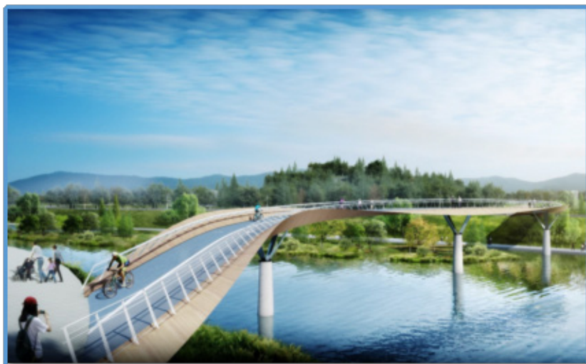
图1 龙岗河四号桥 UHPC 桥墩
